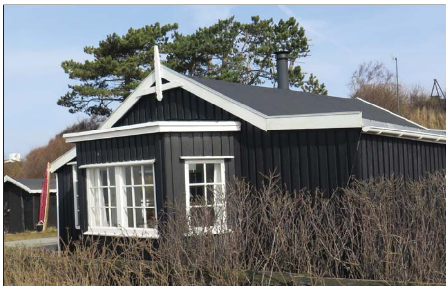
Et typisk ældre sommerhus, opført med træbeklædning og taget dækket med tagpap.
